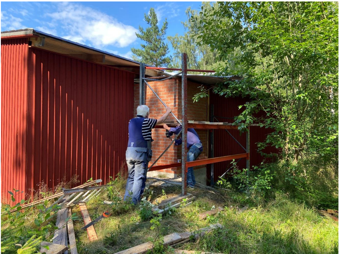
Ställningsbygge för eldstaden i nya uthusbyggnaden.
