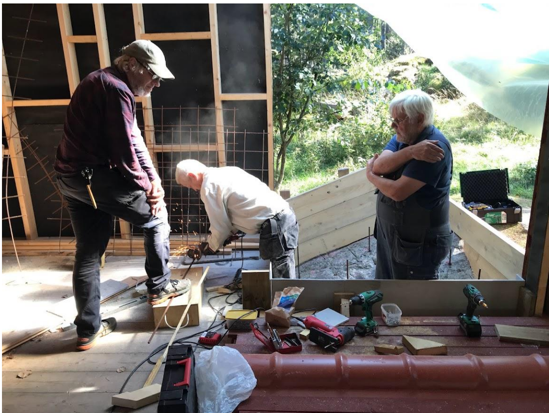
Formsättningsarbete för murstock i uthusbygget.
