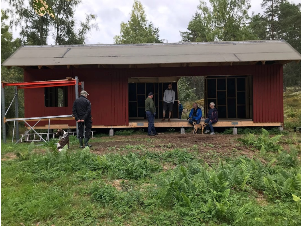
Uthuset i början av september 2022.
