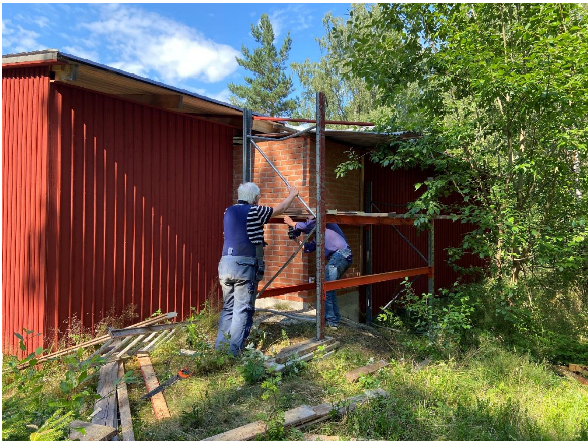
Ställningsbygge för eldstaden i nya uthusbyggnaden.
