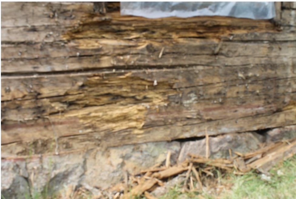
Så här såg väggarna ut när arbetet påbörjades.
